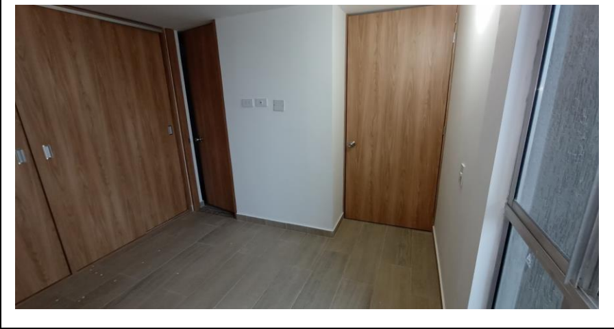
Descripción HABITACION PRINCIPAL TERMINADA
