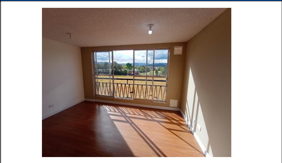
Descripción PAÑETE EN MUROS CON MORTERO SECO CEMEX + ESTUCO Y PINTURA
